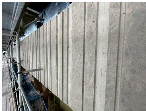
写真-5 バルコニー出来形
