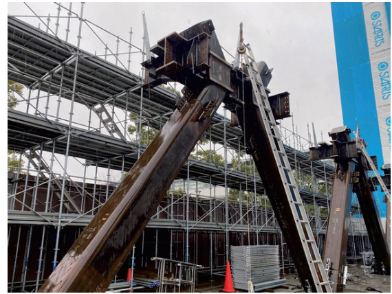
写真-10 斜め柱建方状況
