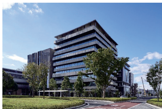
写真-1 建物外観
