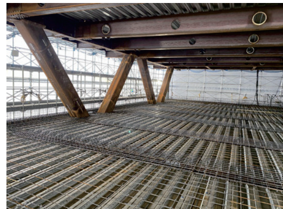
写真-12 斜め柱建方完了状況
