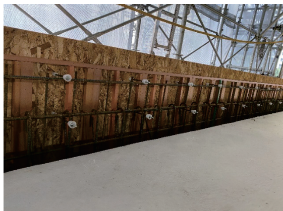
写真-4 バルコニーOSB板型枠施工状況
