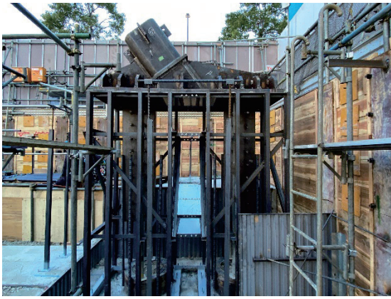
写真-7 斜め柱設置架台
