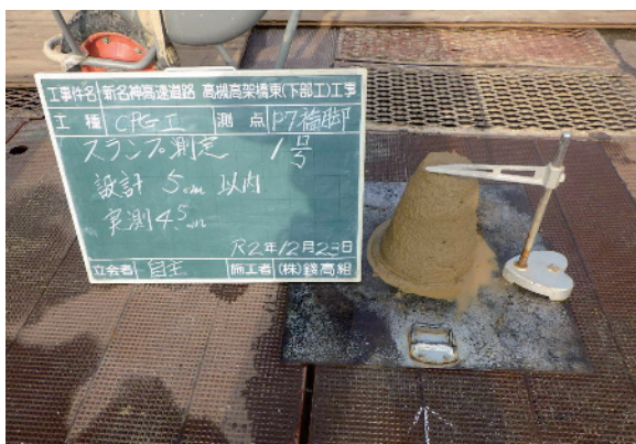
写真-6 中性固化材スランプ試験
