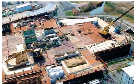
写真-7 施工状況全景
