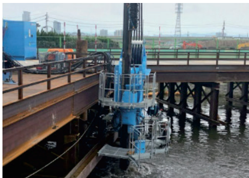
写真-3 硬質地盤クリア工法による鋼矢板締切状況
