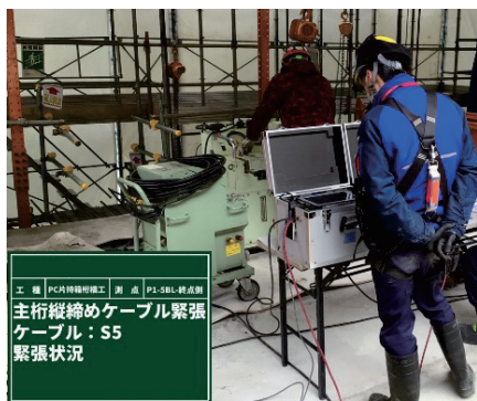
写真-8 緊張管理状況
