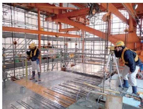
写真-1 型枠セット時の測量状況(従来)
