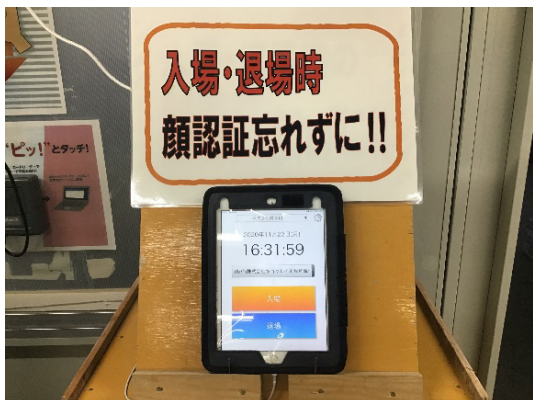
写真-17 端末の詰所設置状況認証状況
