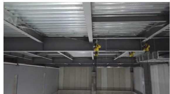
写真-24 吹抜け上部点検
