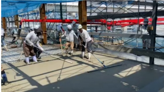
写真-22 全体の作業状況
