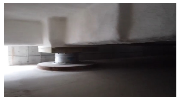
写真-25 ピット内点検
