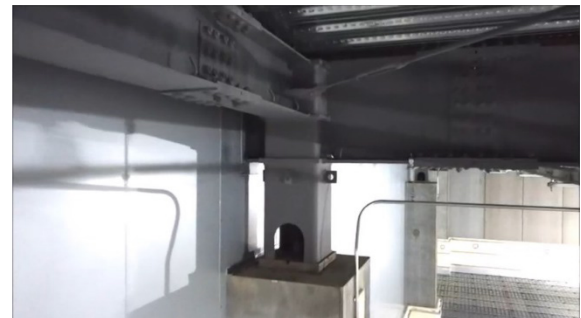
写真-23 PCa 柱上部の点検
