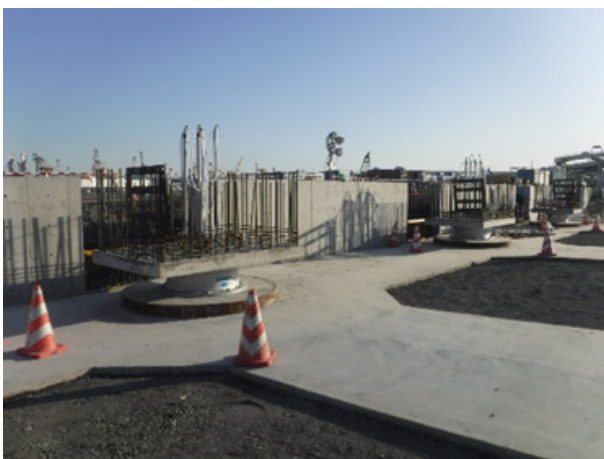
写真-3 杭頭免震構造
