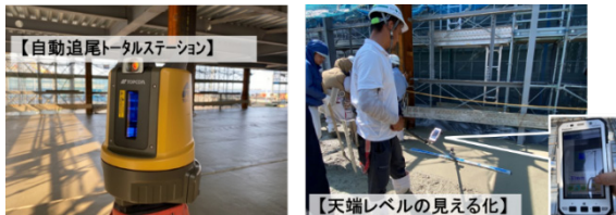
写真-21 自動追尾装置と作業状況
