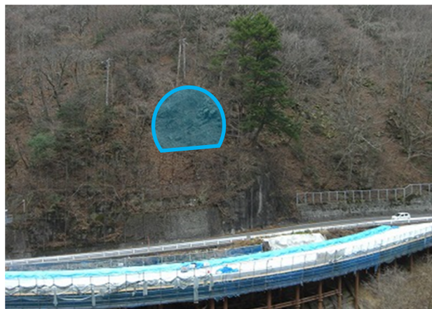
写真-1 到達側坑口位置
