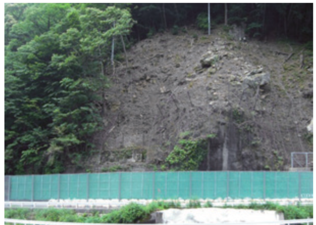
写真-5 落石防護柵設置状況
