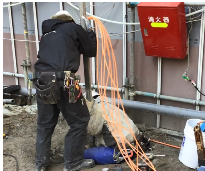
(b) 傾斜計の設置
