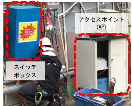
(c) 機器の設置
