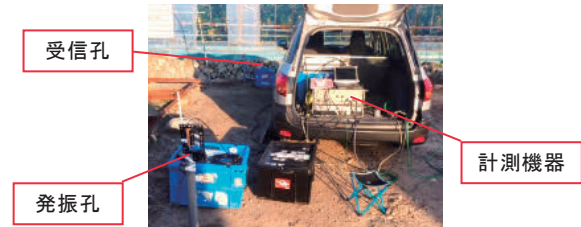
写真-3 音響トモグラフィ探査の状況
