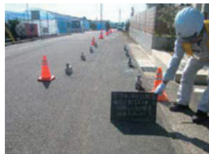
写真-1 微動チェーンアレイ探査の状況
