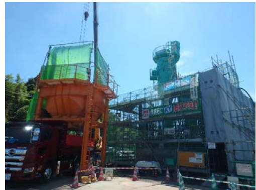
写真-10 ニューマチックケーソン施工状況
