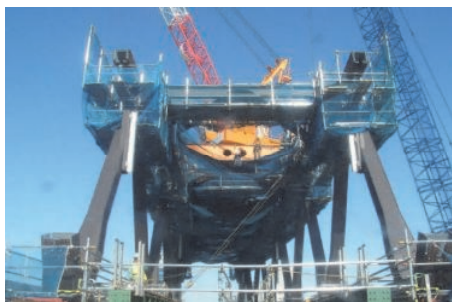
写真-3 ねじれ修正状況
