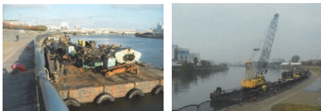
写真-2 台船係留・クレーン組立状況
