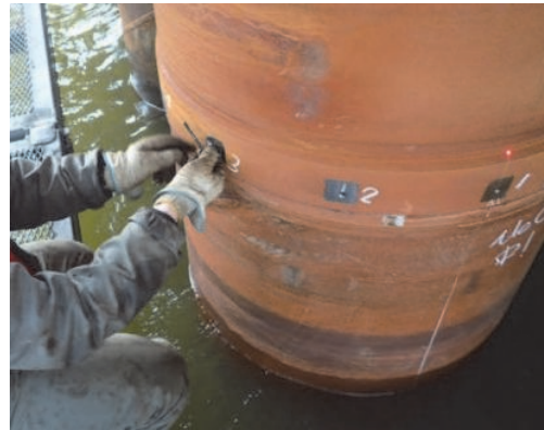
写真-5 六角レンチにて締め込み
