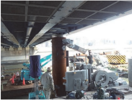
写真-4 鋼管矢板建込み状況
