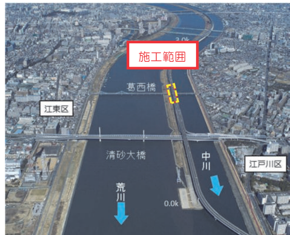
写真-1 施工場所全景
