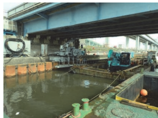
写真-3 葛西橋直下部 施工状況
