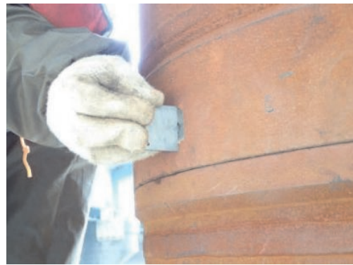
写真-6 深さゲージにて締め込み確認
