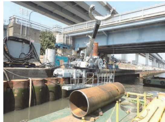
写真-2 吊り込み装置
