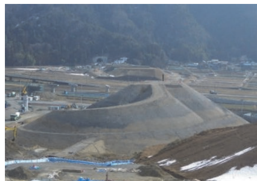
写真-2 盛土の完成全景
