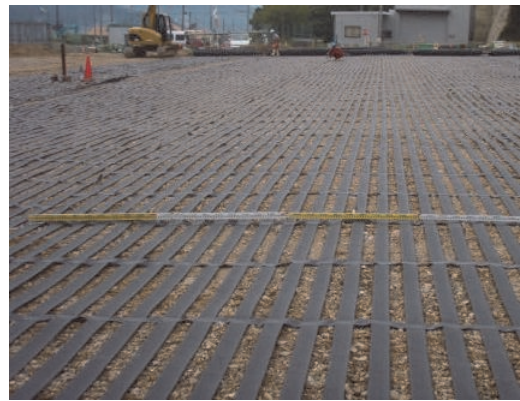
写真-1 ジオテキスタイルの敷設状況
