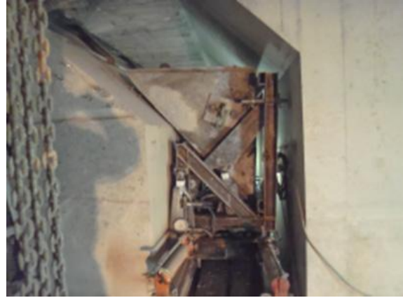
写真-7 切断ブロック取込み完了
