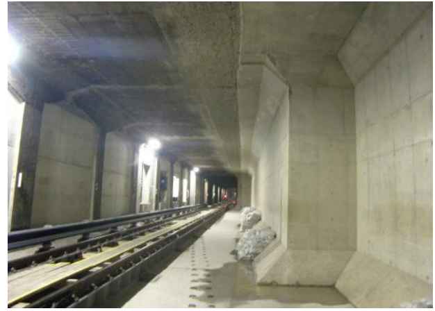
写真-9 第4号線接続部
