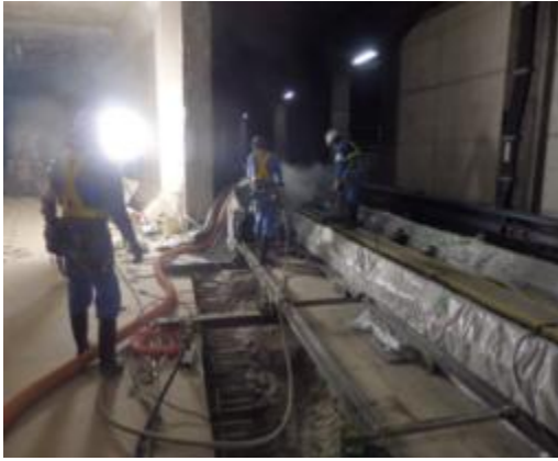
写真-5 軌道内 WJ 施工状況
