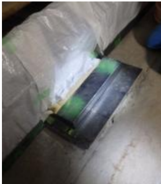
写真-6 台座部プロテクター設
