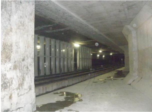
写真-8 第3号線接続部
