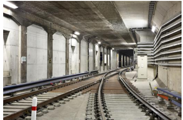
写真-11 第4号接続部（軌道工事完了）
