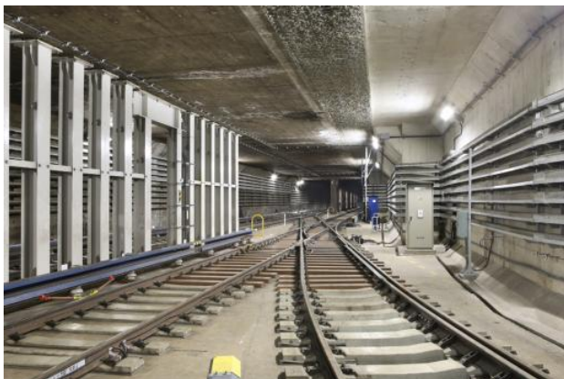
写真-10 第3号接続部（軌道工事完了）
