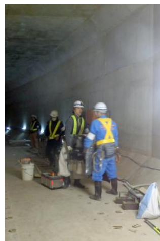
写真-4 WJマシン人力運搬状況
