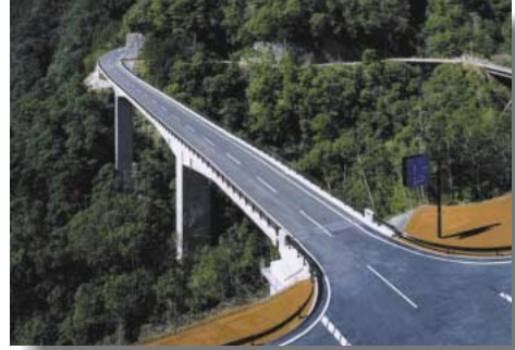
国土交通省近畿地方整備局 奥瀬道路葛川橋(和歌山)
