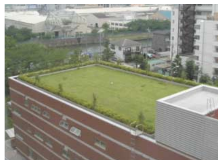
屋上緑化(東京都)
