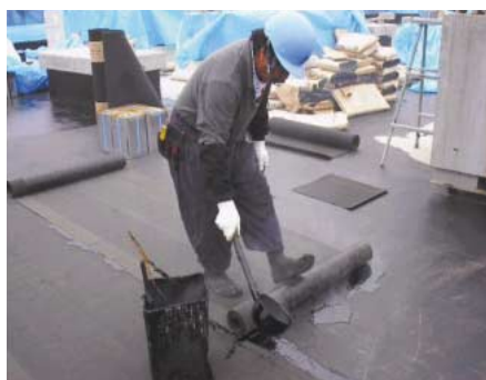
アスファルト防水の施工状況
