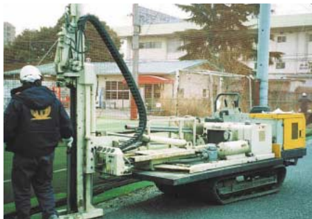
ボーリング調査
